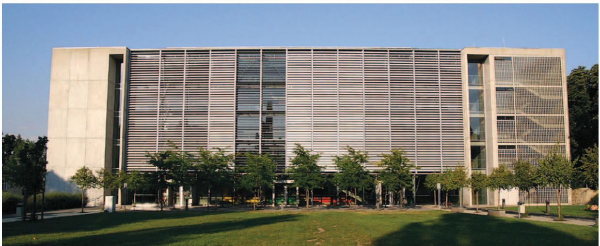
Hörsaalzentrum der TU Dresden (© Sebastian Terfloth 2007)
